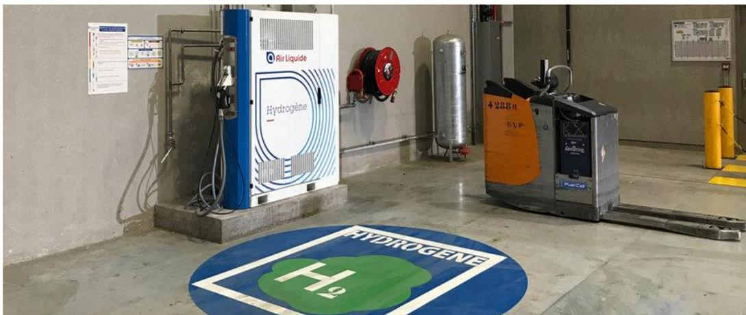
Figura 12: Esempio di stazione di servizio di idrogeno interna e carrello nell'esperienza della Carrefour [62].
